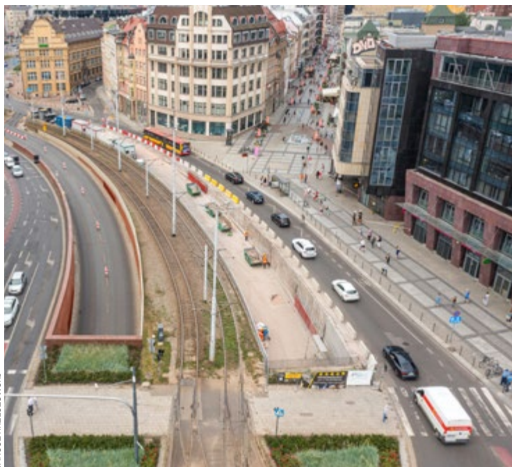
Na czas remontu objazd poprowadzono przez tory i pas zieleni
